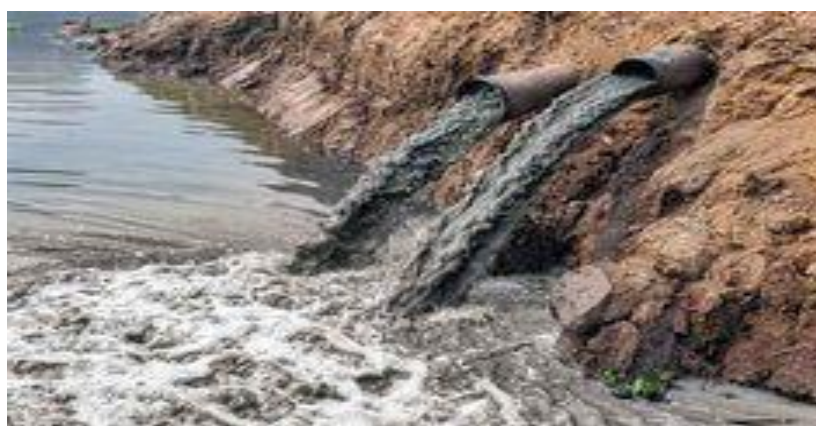
Figura. 1.2. Descargas controladas de aguas residuales
